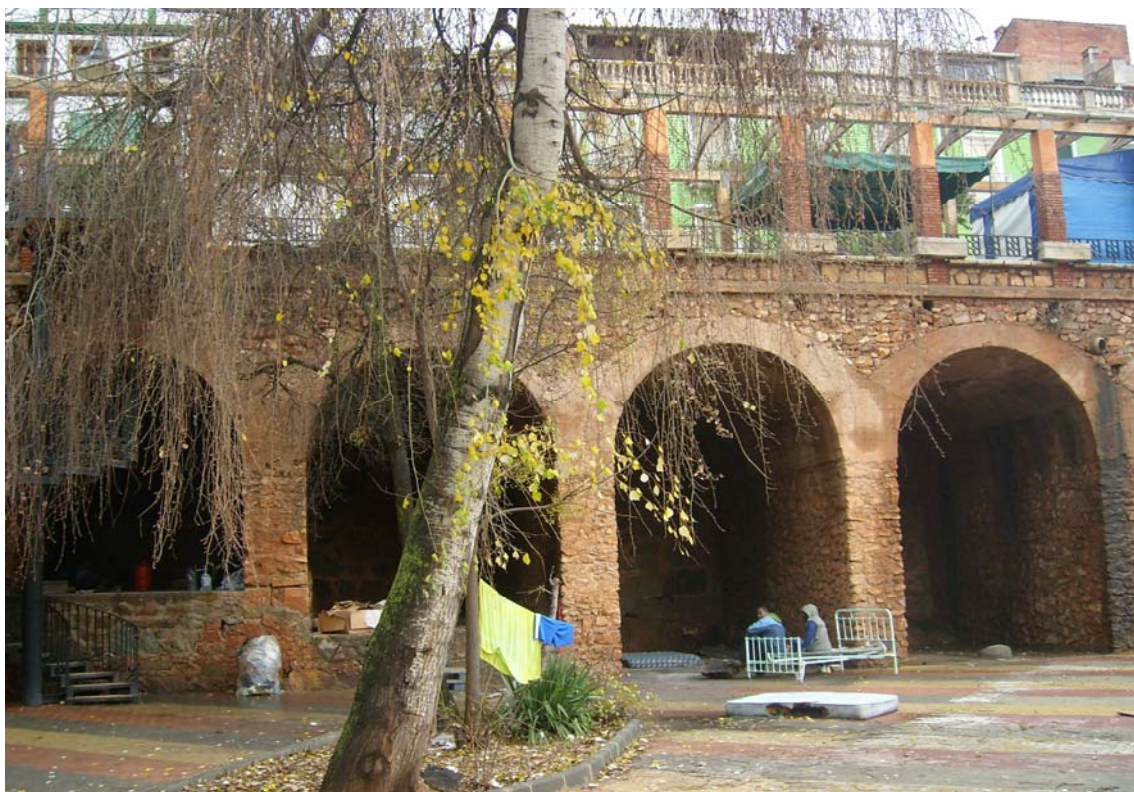
Situación de los inmigrantes en La Puerta de segura
